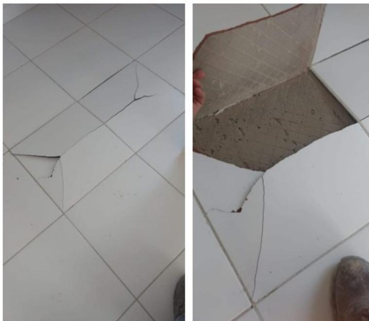
Figura 2 – Vista dos revestimentos cerâmicos bem aderido de um piso interno: expansão com fissuração e “flambagem” da peça. Dimensões das placas: 41 x 41 cm (Fonte: autor).
