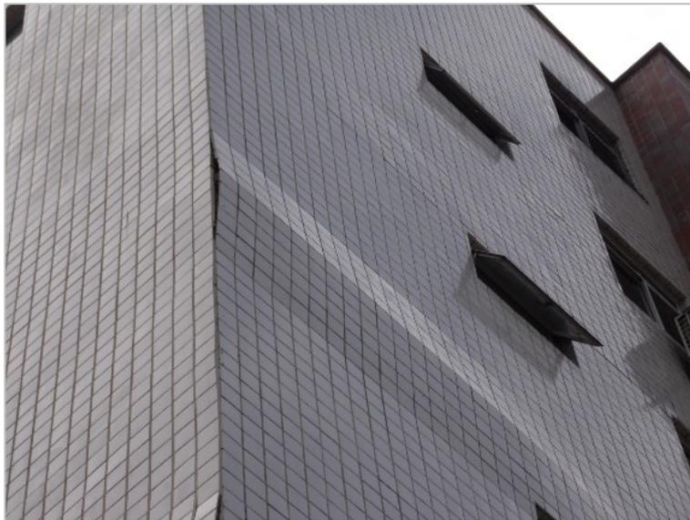
Figura 1 – Vista dos revestimentos cerâmicos de uma fachada: expansão com descolamento generalizado após “flambagem” das peças. Dimensões das placas: 5 x 23 cm (Fonte: autor).
